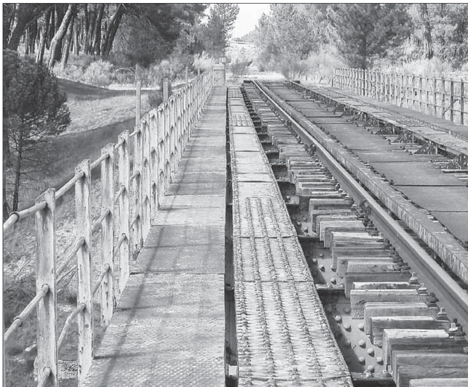
El puente del tren a su paso por el río Voltoya será una de las zonas cuya intervención está prevista para convertir la antigua línea Segovia-Medina del Campo en vía verde.
