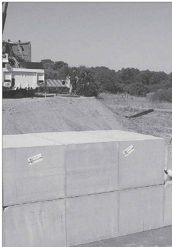
Construcción de un pontón en la carretera provincial 23, tramo Muñopedro-Labajos.
