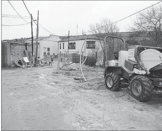
Imagen de los trabajos que se efectúan en la calle Los Molinos. / F. PEÑALOSA
