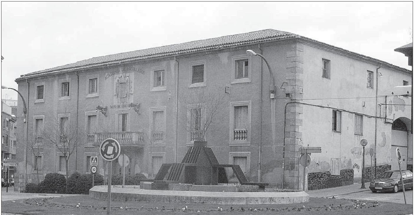
La primera fase de las obras, que se afrontará con 2,4 millones procedentes de los fondos Feder, servirá para sanear la zona del antiguo Regimiento, antes de comenzar la construcción / FERNANDO PEÑALOSA
