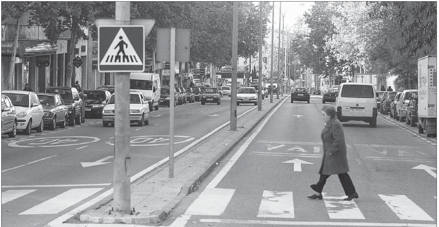
Conde Sepúlveda será una de las vías que vean mejorados su aspecto externo y sus saneamientos gracias a este proyecto, que podría estar concluido a finales del año 2006/JUAN MARTÍN
