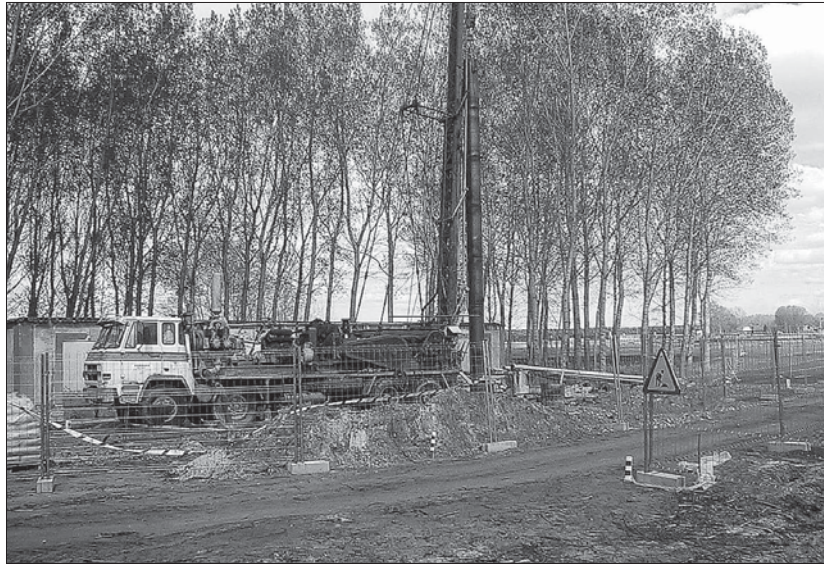
Imagen de archivo de la maquinaria situada junto a los lavaderos, donde se ha realizado el sondeo / F. D.
