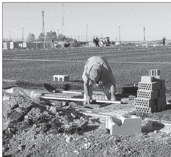
El campo de hierba artificial aún no ha terminado las obras / KAMARERO
