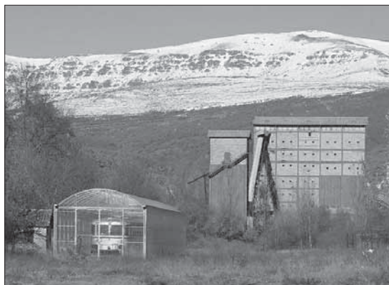
Instalaciones mineras en la zona palentina de Barruelo de Santullán. / C. MANSO
