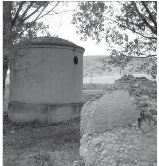
Sondeo actual, situado junto a la antigua fuente Canto / A.PINELA
