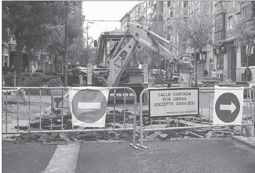
Las obras obligan a los vehículos que circulan por José Zorrilla a desviarse en ese punto hacia la calle Velázquez/JUAN MARTÍN
