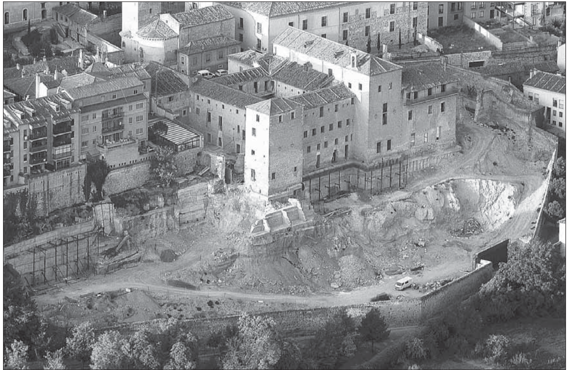
Imagen aérea de las obras de excavación en la huerta del antiguo convento de Las Oblatas, donde se proyecta un aparcamiento subterráneo de 500 plazas/JUAN MARTÍN
