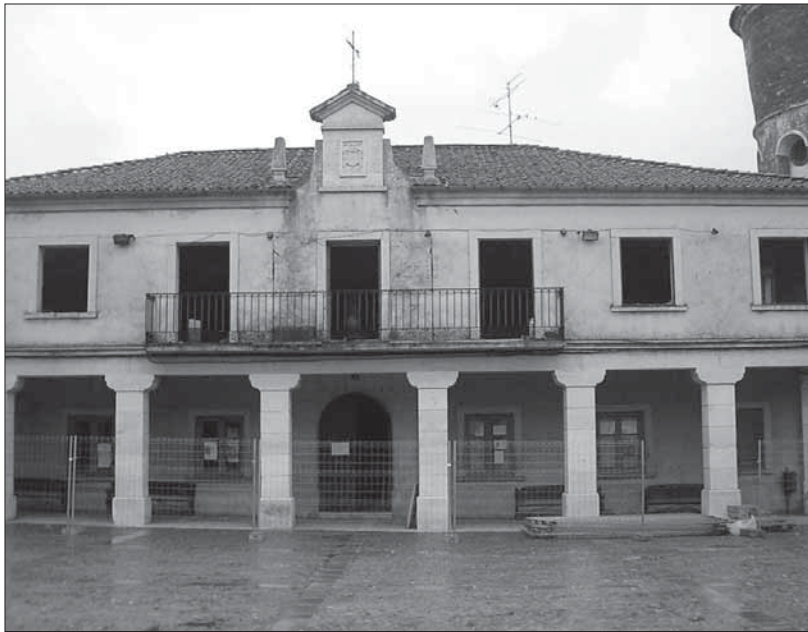
Estado en que se encuentra actualmente el edificio del Ayuntamiento
