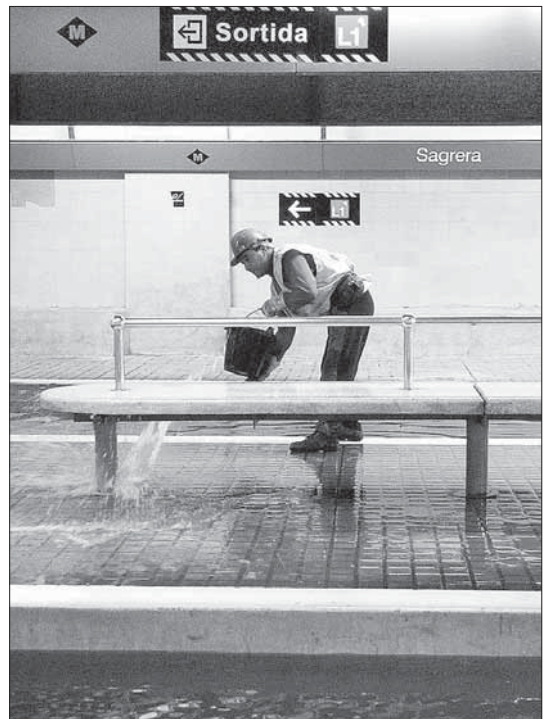
Un operario de la constructora que reforma una línea del metro achica agua. / EFE
