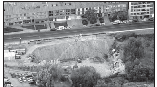
Obras del complejo sanitario Segovia-3, en San Lorenzo
