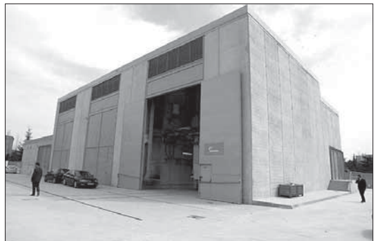
Instalaciones de Iberdrola en la Subestación de La Olma en Valladolid. / ICAL
