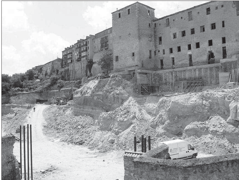
Imagen de archivo de las excavaciones en Las Oblatas, poco después del derrumbe
