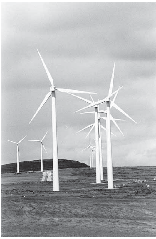
La producción de energía eólica es una de las bases de la planificación. / J. J. MATÍAS
