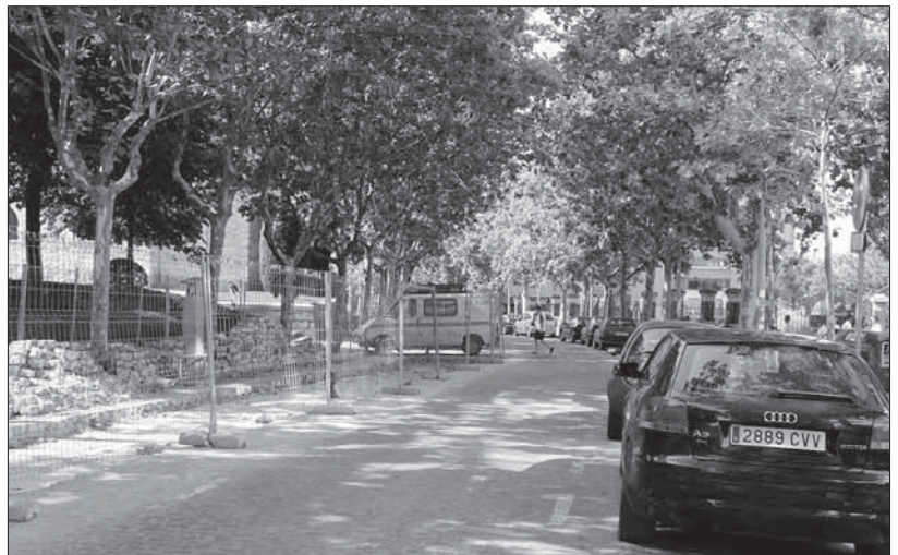
La calle de Santo Tomás quedó abierta al tráfico tras el avance de las obras de saneamiento PEÑALOSA
