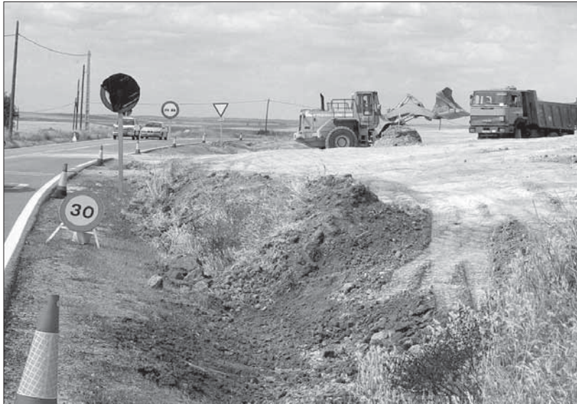
La Junta está ejecutando actualmente obras para hacer autovía el tramo entre Valseca y Segovia PEÑALOSA
