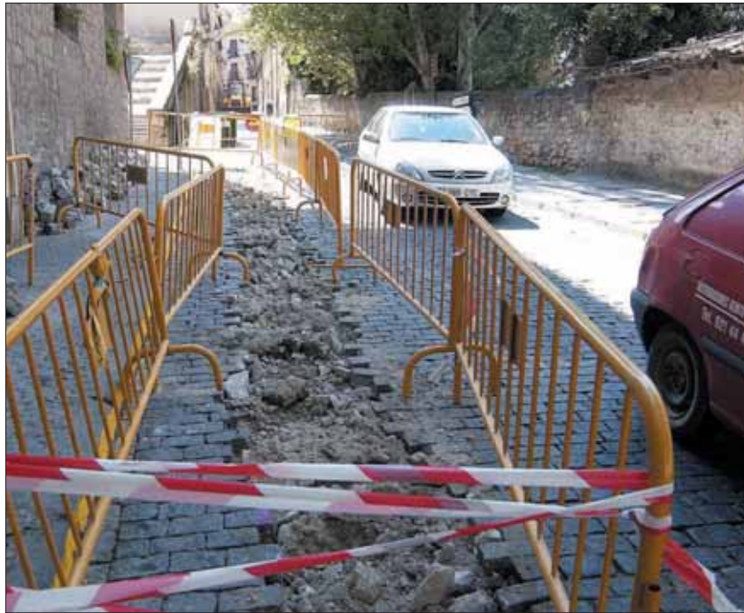
Tramo de la calle Doctor Velasco, cerrada al tráfico, donde se instala una conducción de gas
