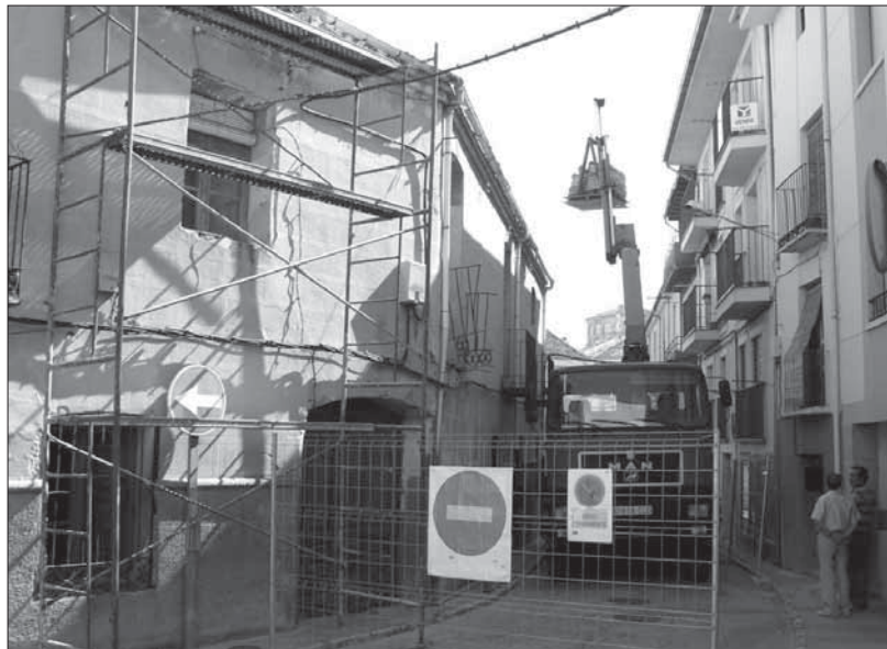
La zona se encuentra cortada al tráfico para el paso de los camiones de obra
