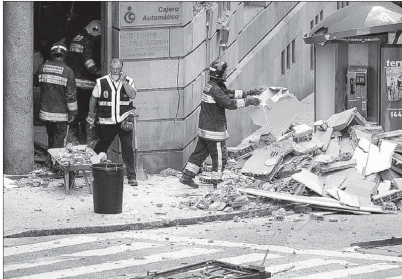
Bomberos y agentes de policía retiran escombros en el lugar en el que se produjo la explosión. / LAVANDEIRA JR (EFE)
