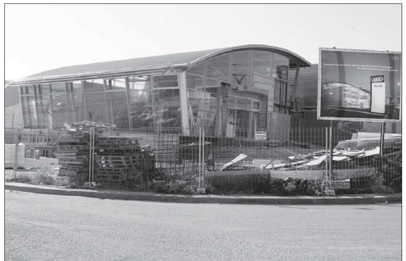
Estado en que se encuentran las obras del futuro hangar, en el Polígono de Hontoria
