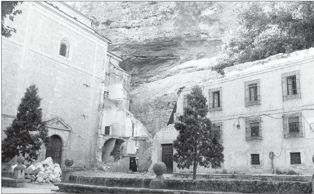
El desescombro ha concluido. En los próximos días se reparará la puerta del templo y se procederá a la limpieza de la zona
