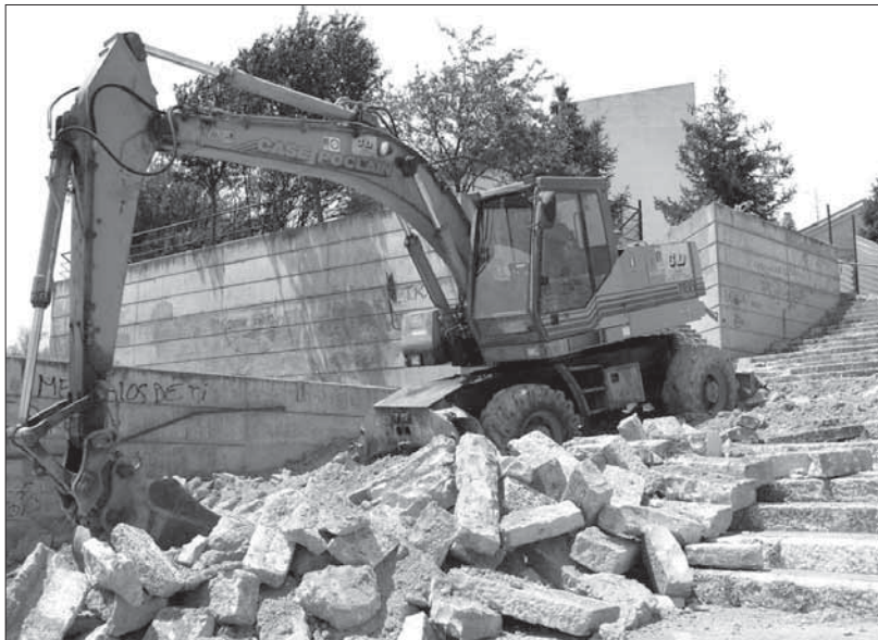
Las obras en la calle Hojalatas se han iniciado esta semana
