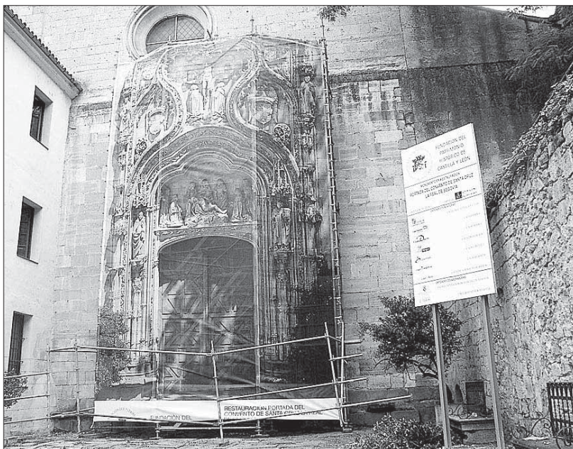
Un trampantojo que reproduce la portada gótica cubre el andamio que soporta las obras
