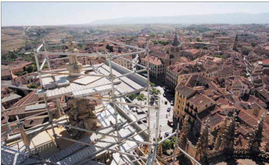
El cimborrio, que permanecerá rodeado de andamios unos meses más, ofrece una magnífica vista de la ciudad y su entorno
