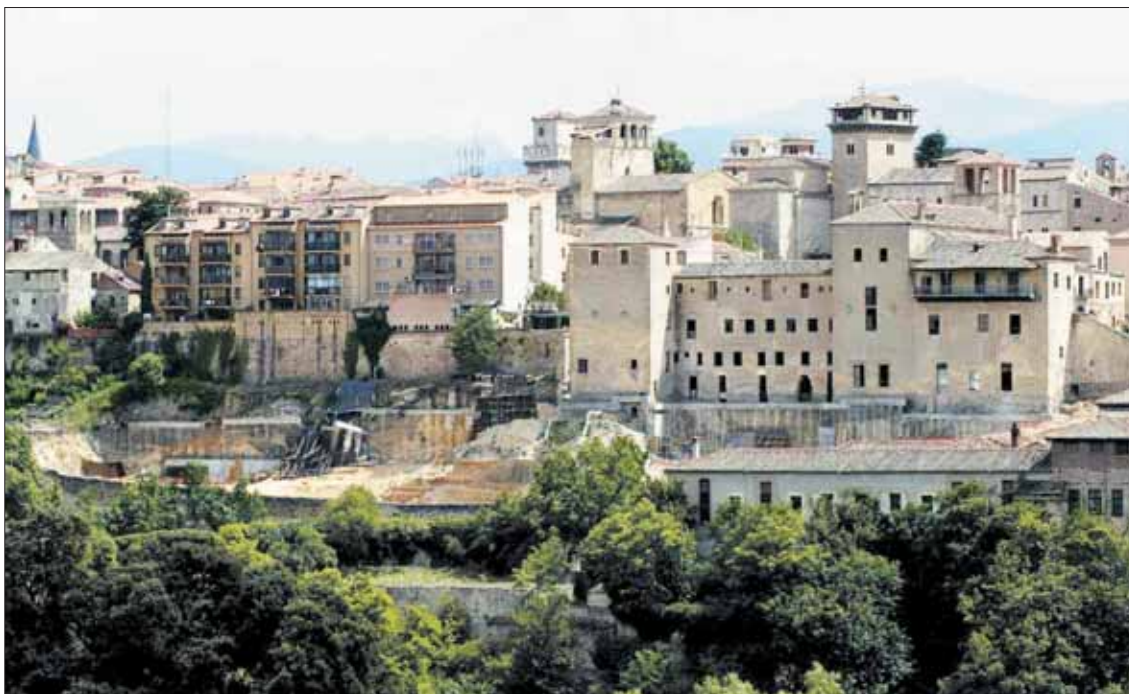
Panorámica de las obras que se ejecutan en el solar de Las Oblatas, con la excavación de la huerta para la construcción del aparcamiento A.MARTIN
