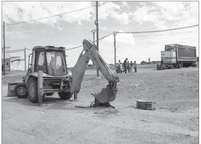
Una excavadora de una compañía eléctrica trabajaba ayer en el recinto ferial de Nueva Segovia J.MARTÍN
