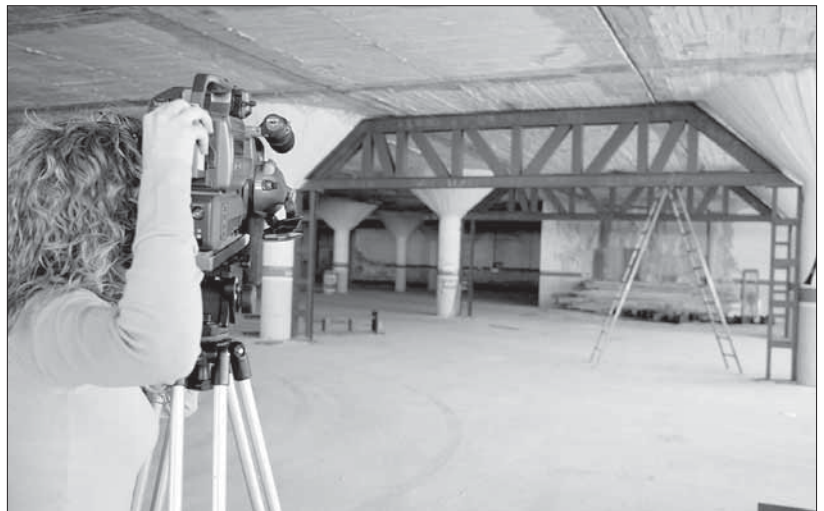
Al fondo, una de las 17 vigas que han sido incorporadas para reforzar el forjado del parking
