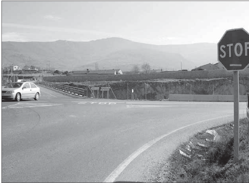
Estado actual del acceso a Otero de Herreros desde la N-603
