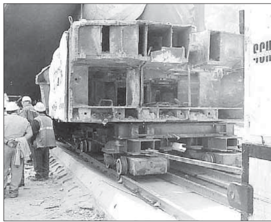
Algunas de las piezas de la tuneladora, ya desmontadas
