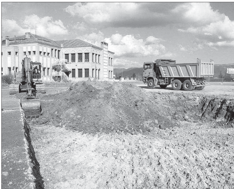
Los trabajos de excavación para la construcción del hotel comenzaron hace unos días
