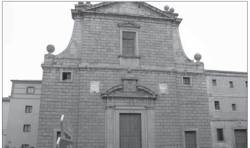
Los dos millones del ministerio se destinarán a restaurar la parte noble del Seminario
