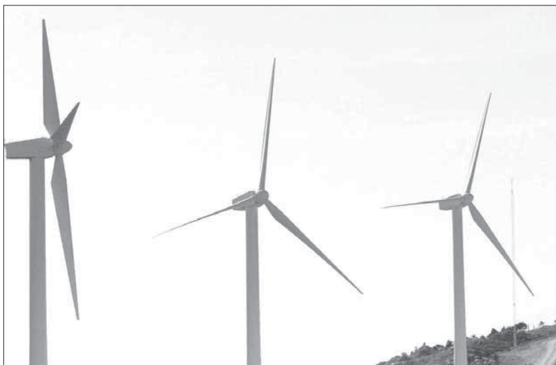
Los aerogeneradores han sido instalados en los últimos meses cerca de Carabias
