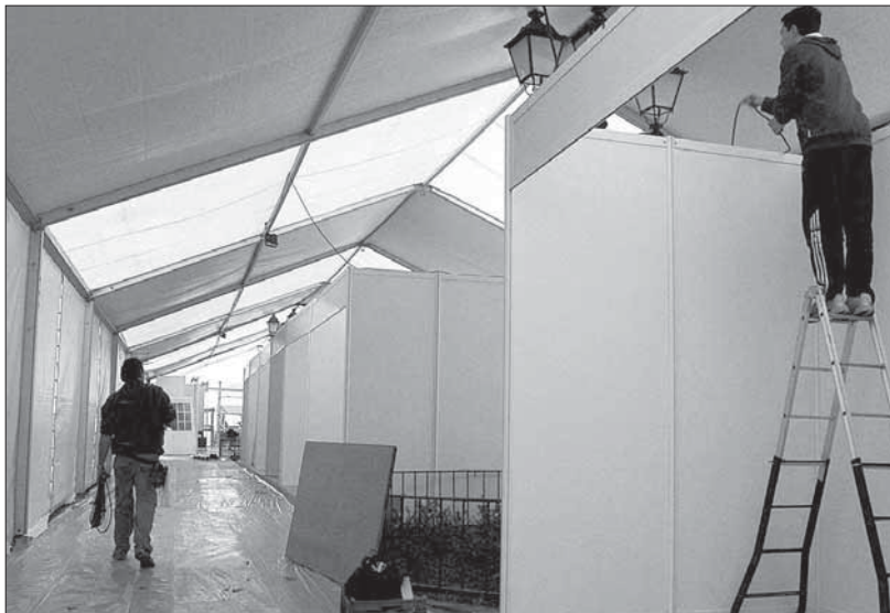
Trabajos de instalación de la carpa que acogerá a 70 expositores en el paseo de El Salón
