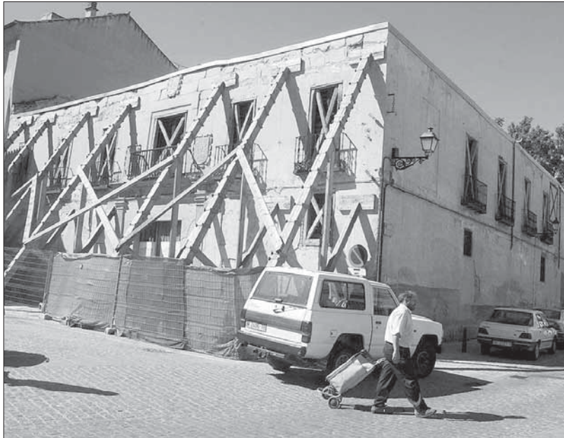
estado actual del antiguo Palacio de Enrique IV, declarado de utilidad pública
