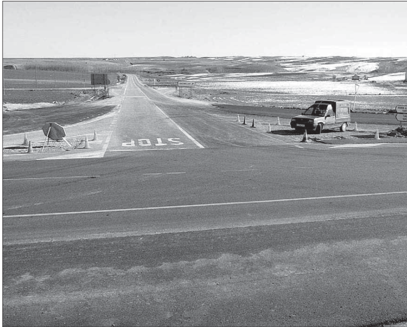
Los trabajos continúan en las zonas ya libres de los trámites administrativos
