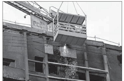
Una imagen de los trabajos realizados ayer en el Windsor. / J. MARTÍN (EFE)
