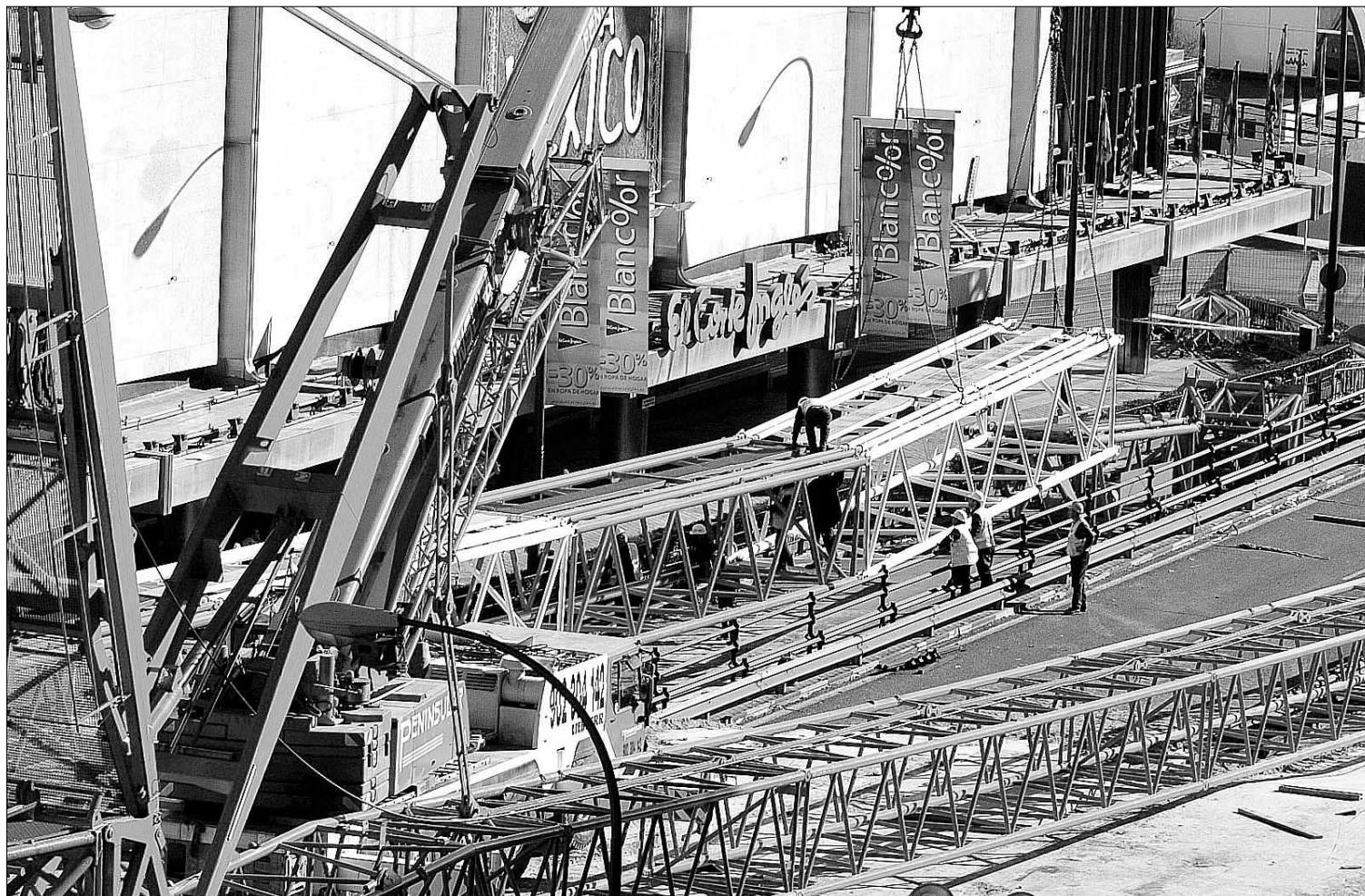
Un equipo de expertos continuó ayer la instalación de cuatro grandes grúas para desmontar las ruinas calcinadas de la torre Windsor de Madrid. / ANGEL DÍAZ 8EFE
