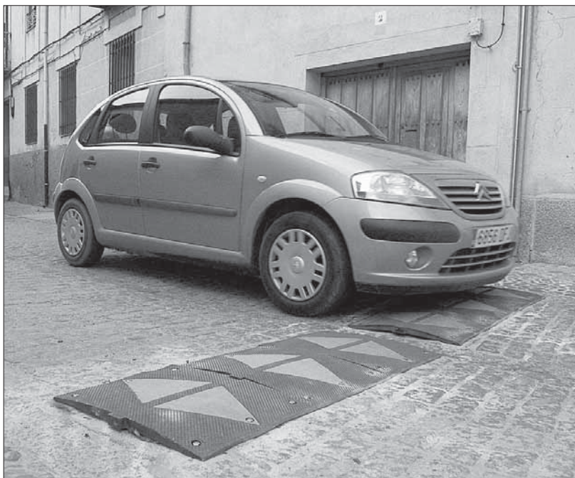
Una de las bandas sonoras instaladas en la Ronda de Juan II, entre el Alcázar y el arco del Socorro
