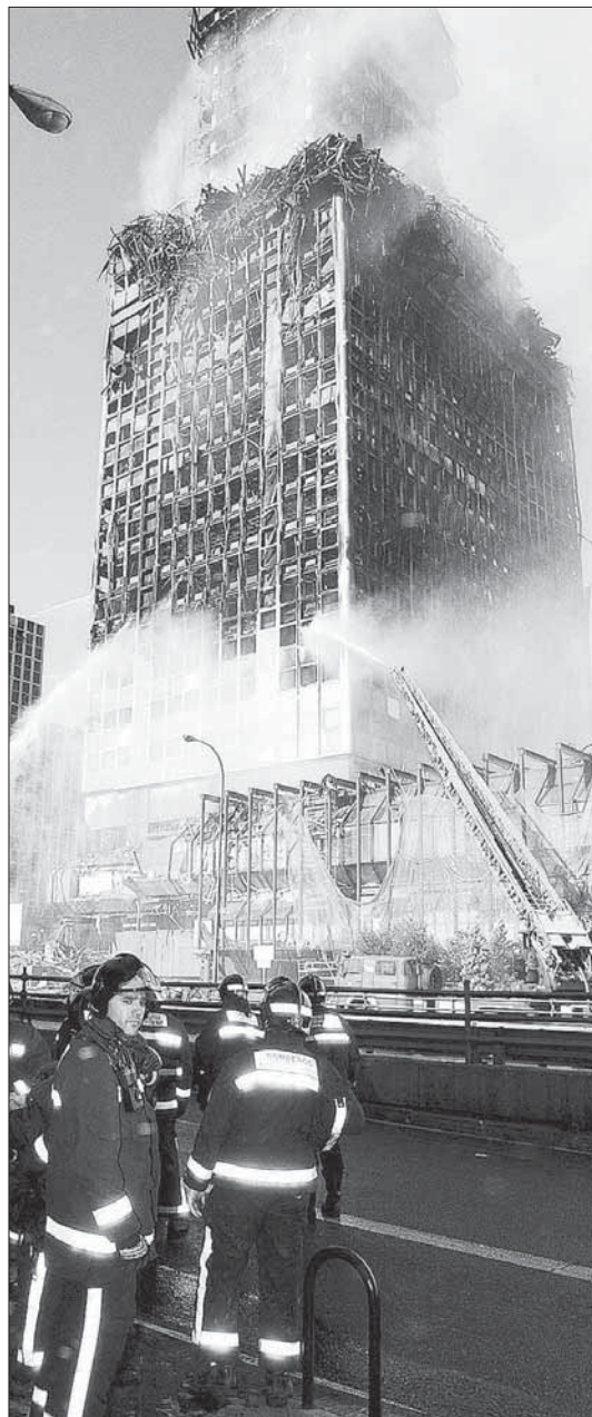
Efectivos del Cuerpo de Bomberos enfrían con cortinas de agua el edificio. / EFE
