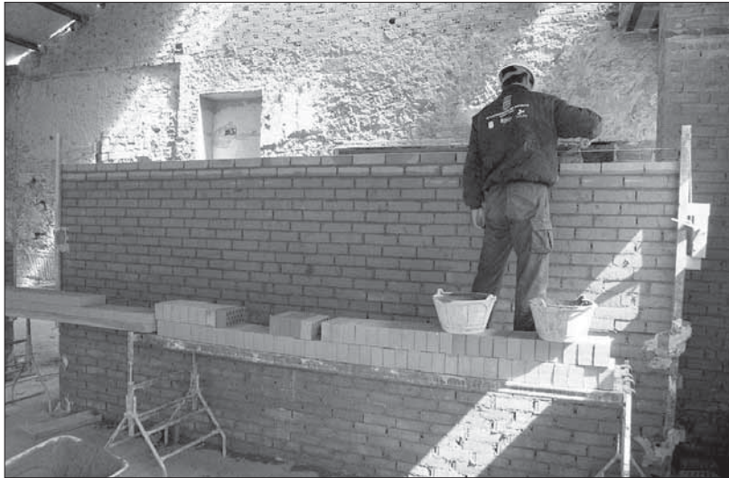
Un alumno de la Escuela Taller trabaja en la construcción de un muro
