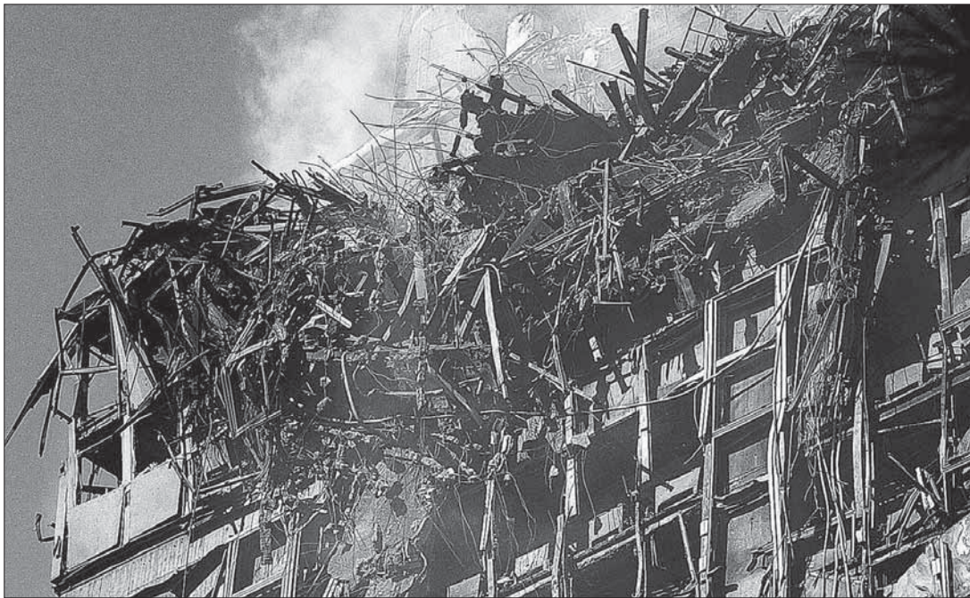
Detalle del estado en el que ha quedado el edificio Windsor después de haber sido devorado por las llamas. / BERNARDO RODRÍGUEZ (EFE)
