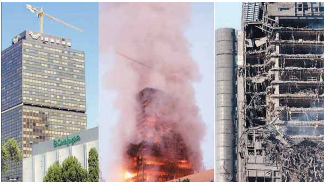
Imagen del rascacielos Windsor antes del incendio y dos secuencias que muestran el fuego y el estado en que ha quedado tras él
