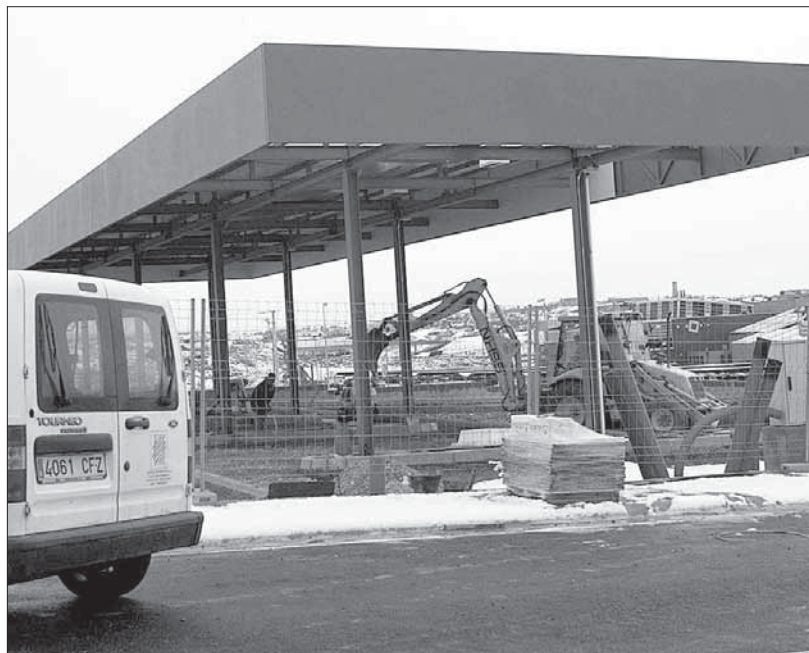
El Grupo Eroski está construyendo una gasolinera junto al centro comercial 'Luz de Castilla' JUAN MARTÍN
