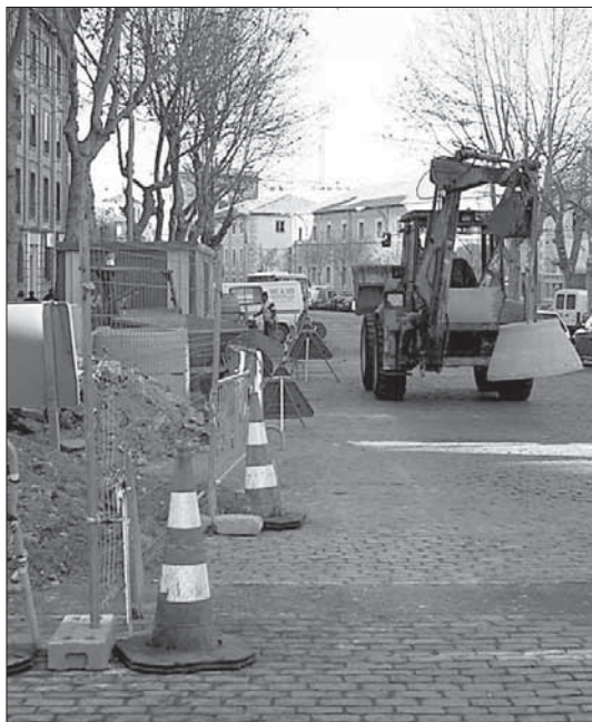
Las obras tienen un presupuesto de unos 73.400 euros
