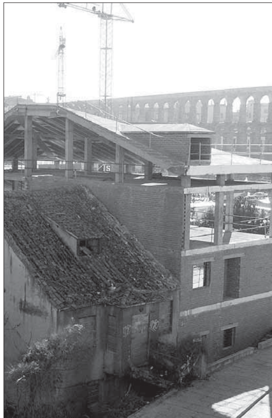
Las obra permanecen paralizadas desde diciembre
