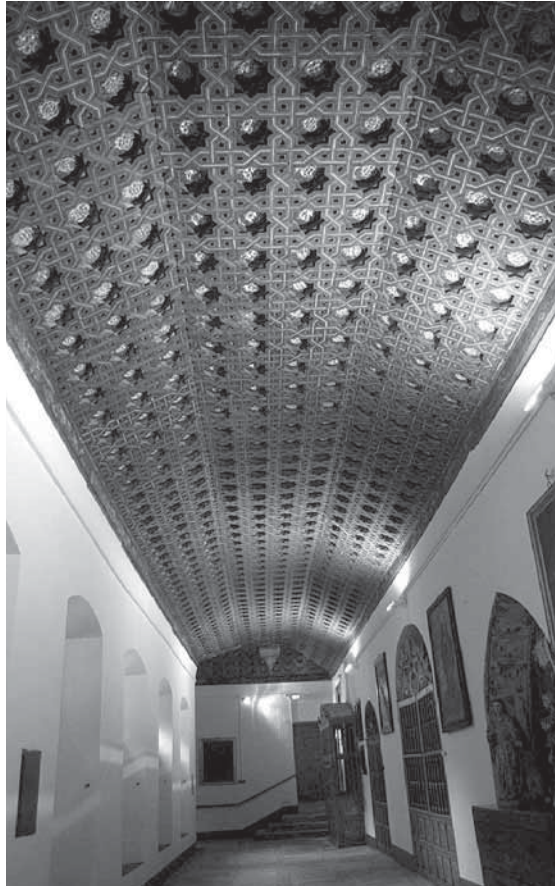
Los techos del claustro tienen un artesonado en muy buen estado/ J. MARTÍN
