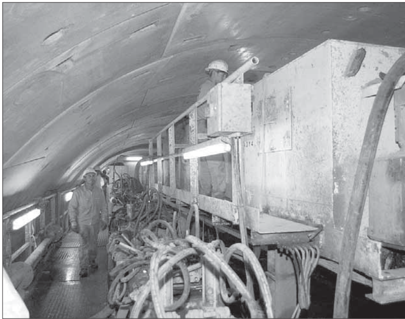
Imagen de una de las máquinas tuneladoras que han operado estos dos años y medio
