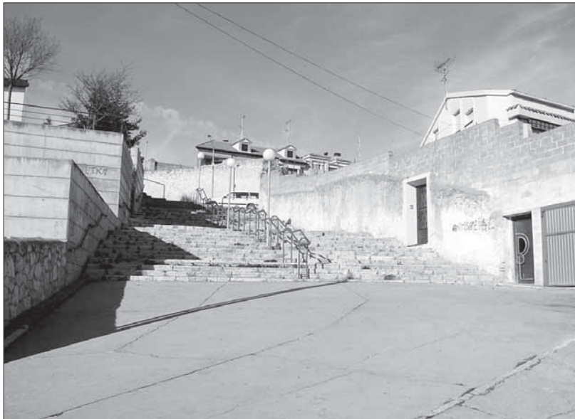
El ascensor se instalará al pie de las actuales escaleras que serán modificadas
