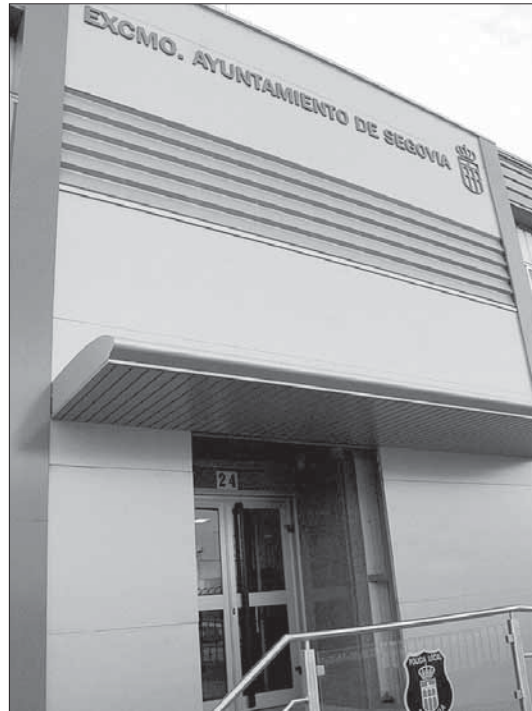
Entrada principal del nuevo cuartel de la Policía Local
