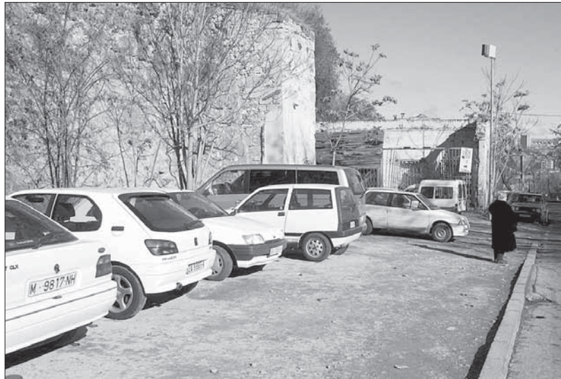
Los edificios, al fondo, serán derribados y el espacio será adecentado y vallado
