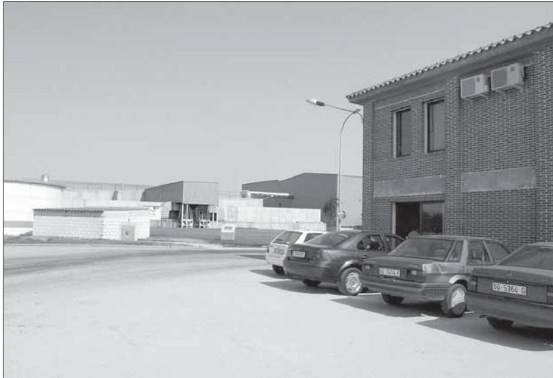
El centro de residuos de Los Huertos fue diseñado en la década de los años 90
