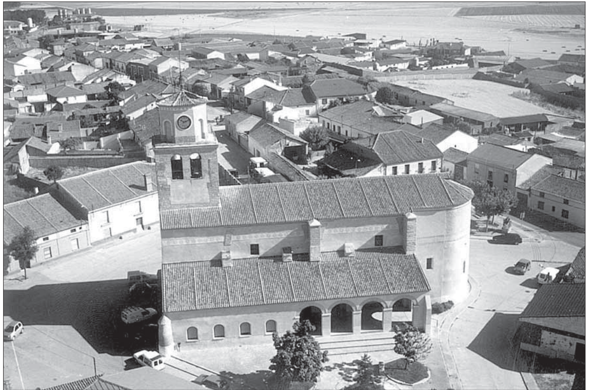
Vista aérea de la iglesia parroquial de Santiuste de San Juan Bautista. El reloj de la torre dará las campanadas de fin de año.
