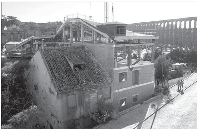
El polémico edificio se construye en el solar que ocupó la antigua clínica de Unión Previsora. JUAN MARTÍN
