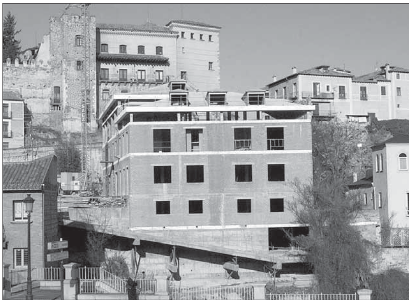
Las obras del polémico edificio, en la Plaza Oriental, se encuentran ya muy avanzadas
