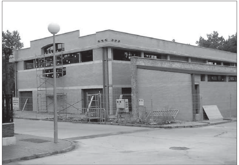
Estado en el que se encuentran las obras del gimnasio del centro
