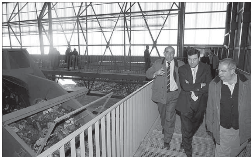
El consejero Fernández Carriedo recorrió las instalaciones del CTR de San Román de la Vega
