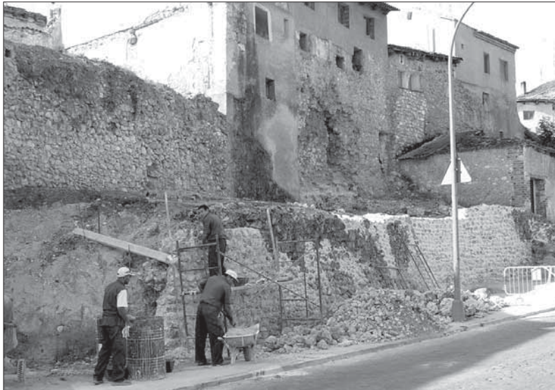
Durante los últimos meses se han realizado trabajos de recuperación de la contramuralla
