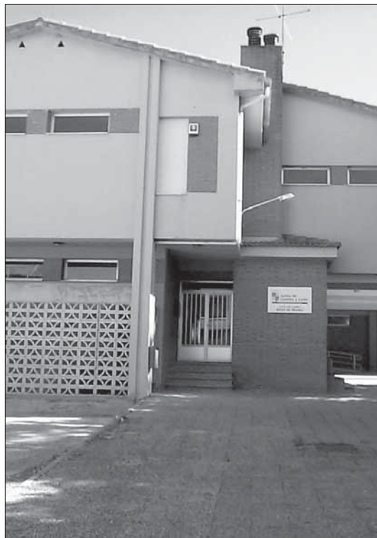
Entrada principal del colegio público de Abades
