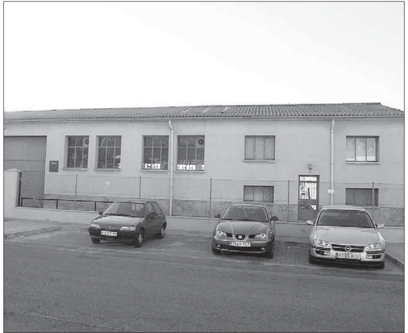
Instalaciones de Telefónica en la calle Guadarrama donde la compañía ha retirado una antena JUAN MARTIN
