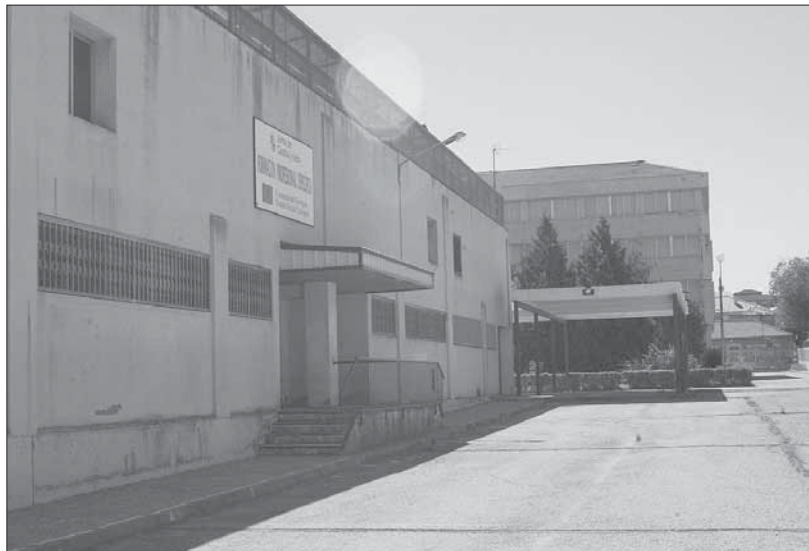
En el IES María Moliner se han realizado obras de reforma que han afectado a la fachada
