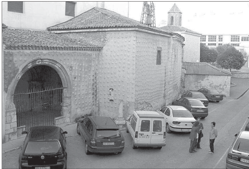
Fachada de la capilla que será acondicionada en breves fechas
