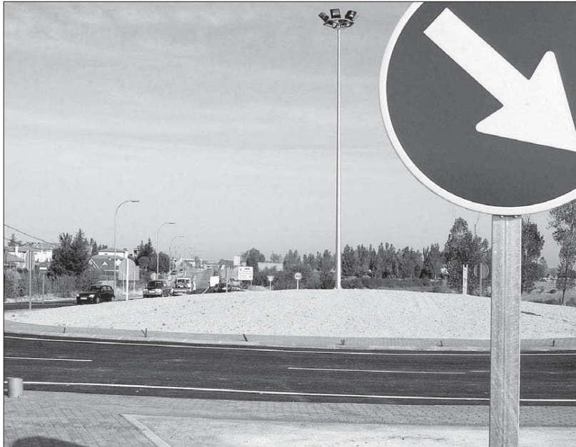
La rotonda situada a la altura de Femsas está pendiente solo de "remates"
