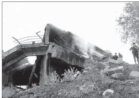
La estructura del edificio afectado quedó destruida por completo. / EFE
