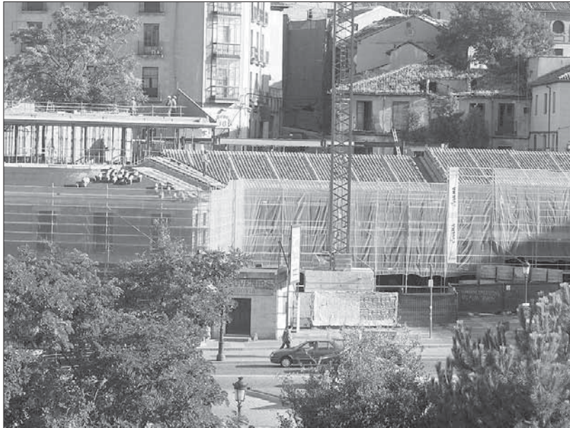
Buena parte del edificio junto al Acueducto tiene ya instaladas las cubiertas
