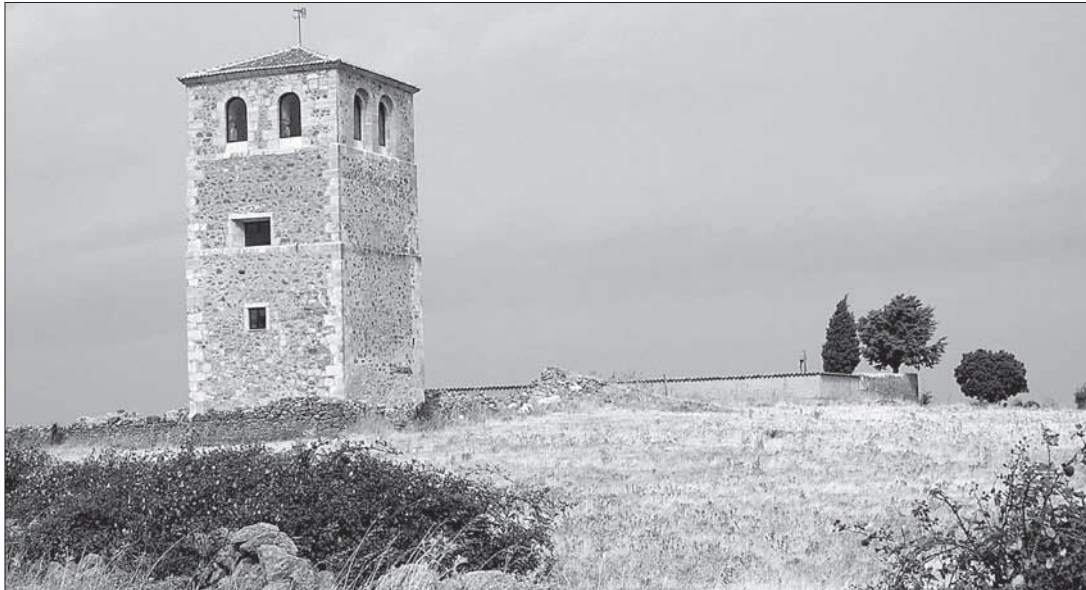
Vista de la torre de Santo Tomé del Puerto, que ha sido recientemente rehabilitada
